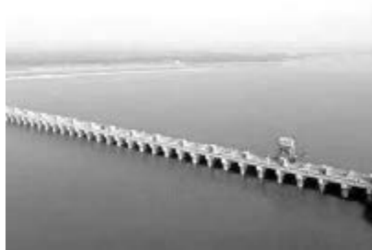
近两年国家大力投资水利，在建水利工
